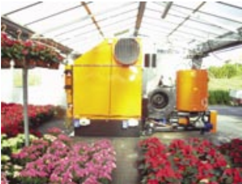
Figura 24. Generatore di aria calda da 190.000 Kcal/h.
