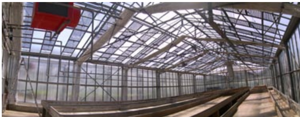
Figura 9. Fase finale dell'installazione dell'Impianto fotovoltaico CIS sulle falde della serra
