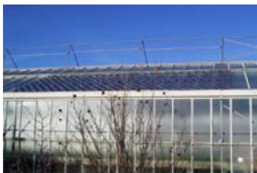
Figura 18. La parte fotovoltaica del tetto delle serra.
