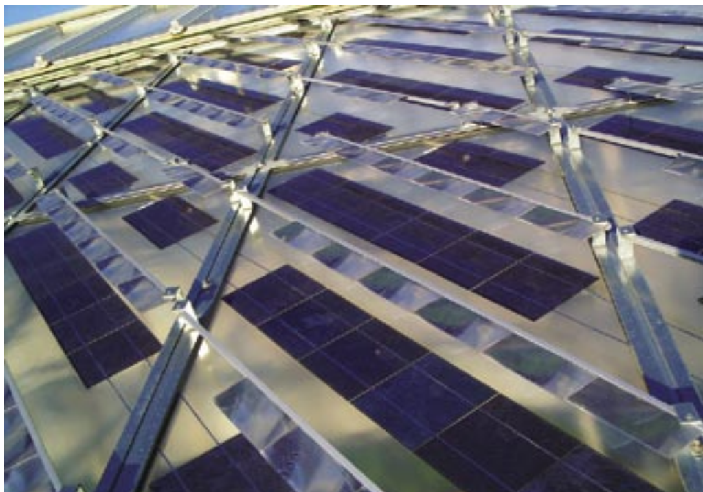
Figura 17. Posizionamento delle celle.
